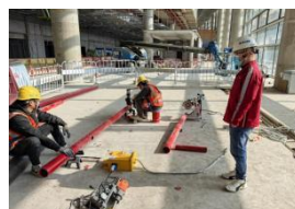
白云机场三期扩建工程T3航站楼项目
