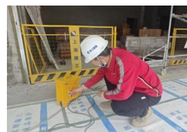
白云机场交通中心综合体项目
